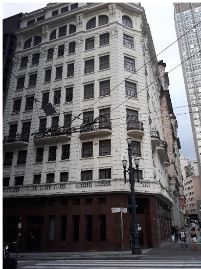
FACHADA DO PRÉDIO 1
